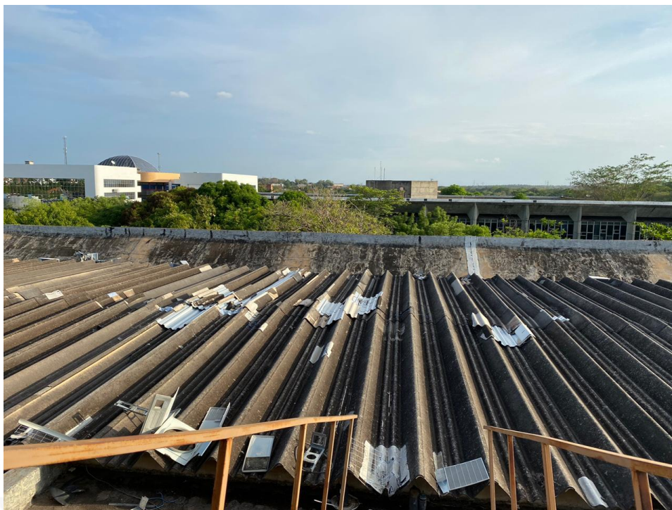
Foto 01: telhado cheio de remendos e buracos
