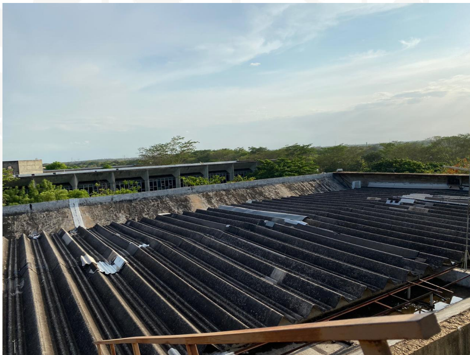
Fotos 02: telhado cheio de remendos e buracos
